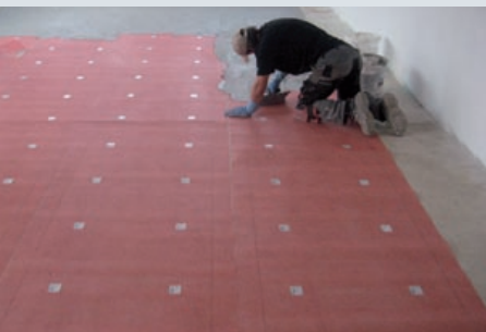
Abb. 5: Erster Abdeckschritt bei der Navi-Floor® Installation mit BARiT® Haftbrücke, Tagraster ist 50 cm.
